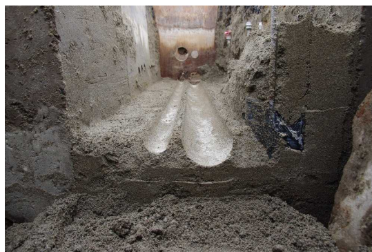
写真-4 管下の充填状況 (下段)
