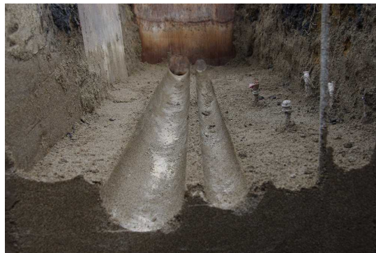
写真-2 管下の充填状況 (上段)
