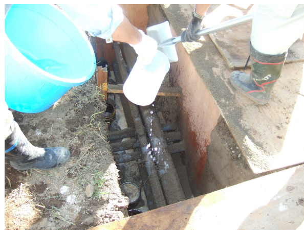
写真-1 水締めによる打設状況
