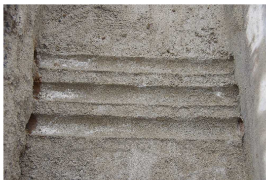
写真-3 管下の充填状況 (中段)
