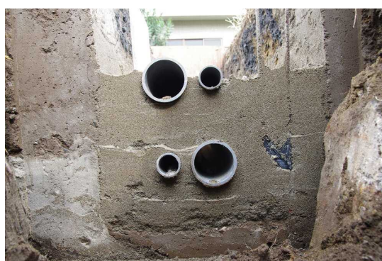
写真-5 管下の充填状況 (側面)
