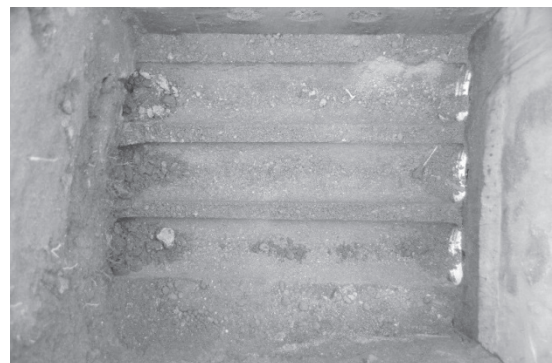
写真-8 下管管下の充填状況 (No. 7-4)
