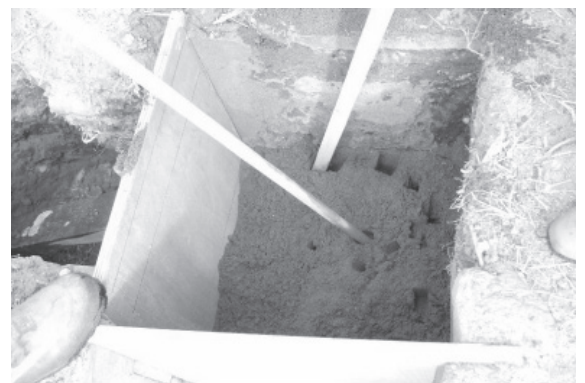
写真-4 突き棒による締固め状況
