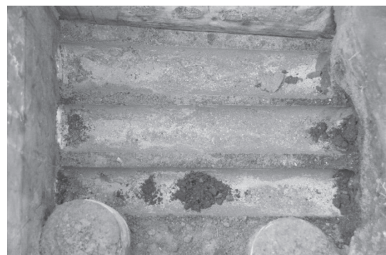
写真-6 下管管下の充填状況 (No. 7-2)
