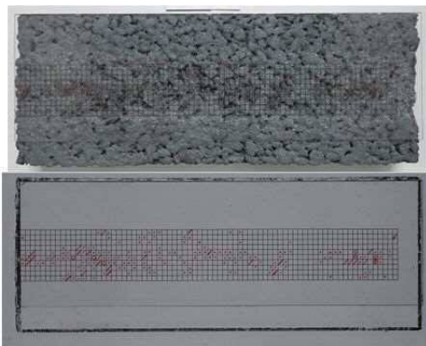
写真-9 はがれ箇所のマーキング状況
