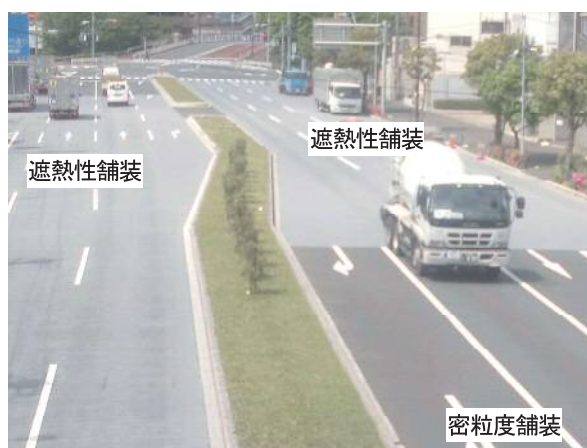
写真-2 観測箇所（遮熱性舗装 施工後）
