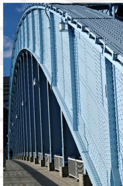
⑬(右) 長寿命化対策後のアーチリブ ライトアップ用の底が撤去され、照明も当初のデザインに復元されたリベットに加えてトルシアボルトが追加されている
