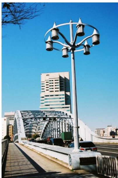
⑩(左) 平成初年の修景事業で改変された橋灯
