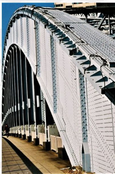
⑫(左) 長寿命化対策以前のアーチリブ ライトアップ用の底が取り付けられていた
