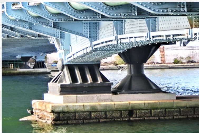
⑭地震時に水平力を受ける支承の増設 (左側が既存支承 右側が増設支承)
