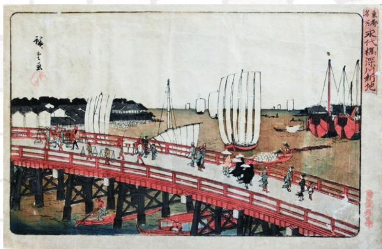
②江戸時代の永代橋「東都名所永代橋深川新地（安藤広重筆）」
