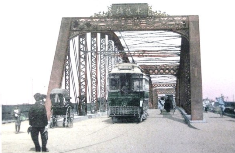
⑥明治30年に鋼プラットラス橋に架け替えられた永代橋
