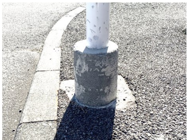
処置後の状況
