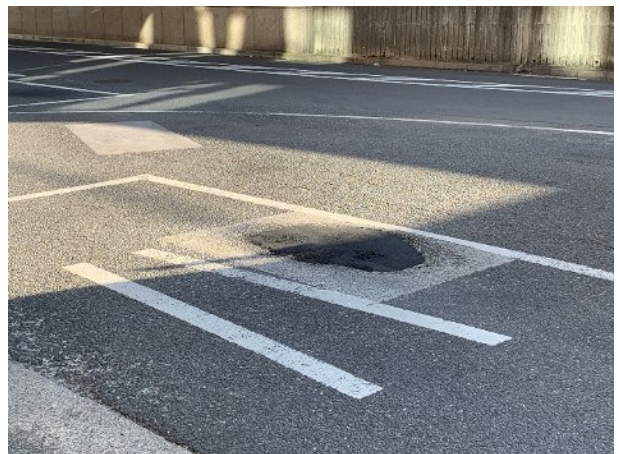
処置後の状況
