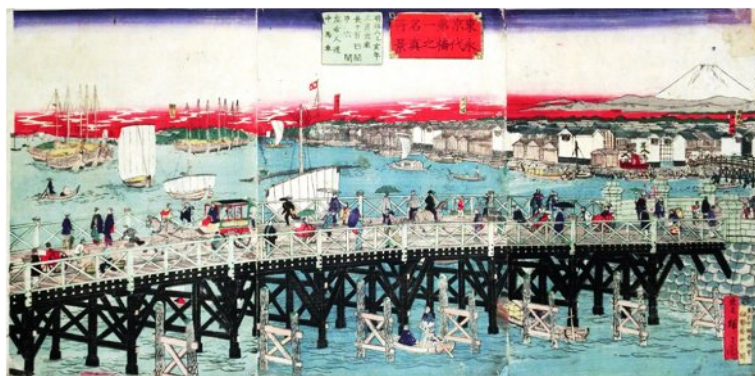
⑤明治8年に木造方杖橋に架け替えられた永代橋 「東京第一名所永代橋之真景（安藤広重（三代））」
