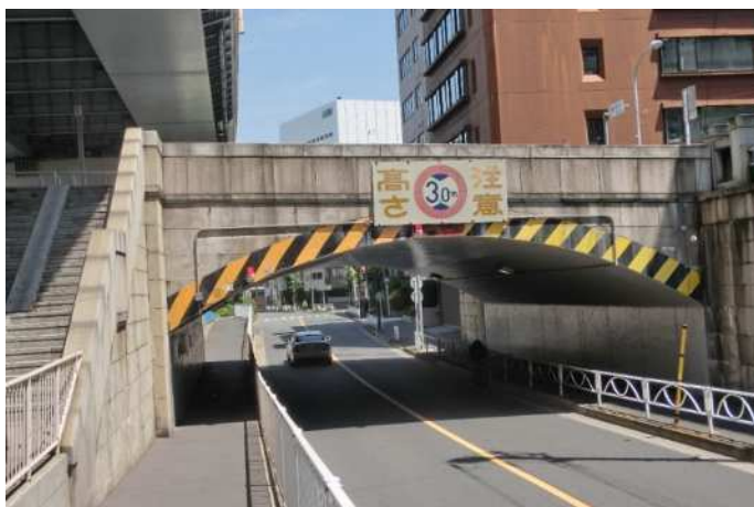
②墨田区側にある側径間の鉄筋コンクリートアーチ橋
