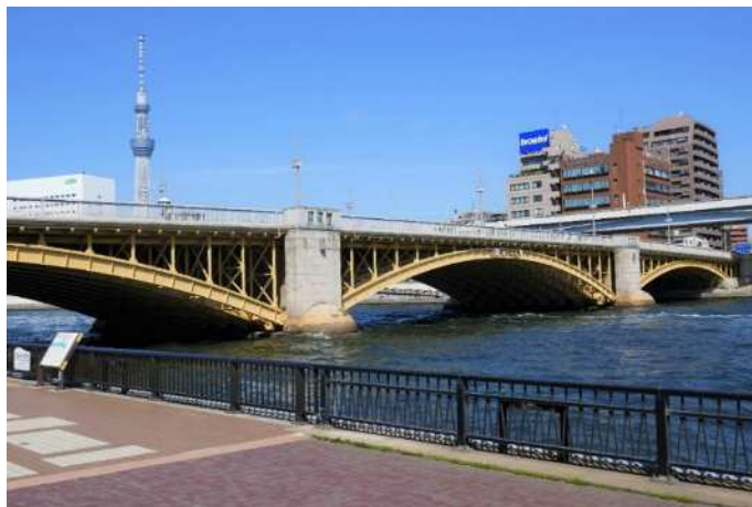
①下流右岸から見た蔵前橋
