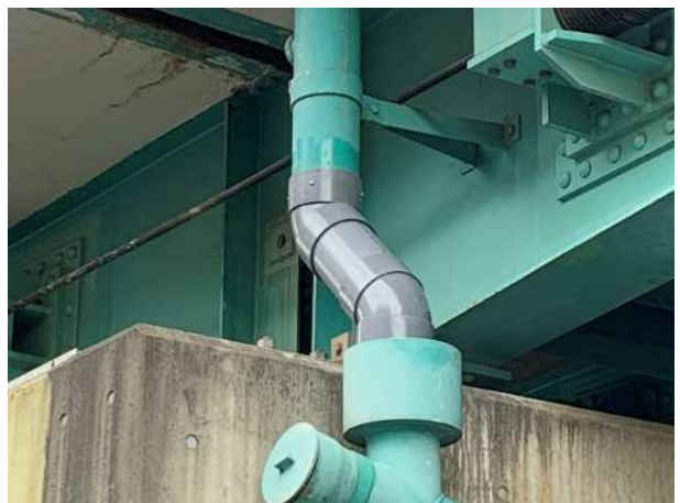
処置後の状況
