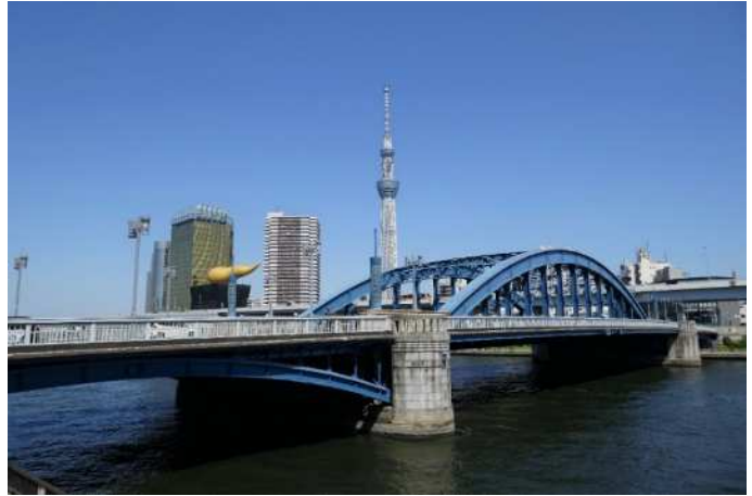
①右岸下流側から見た駒形橋
