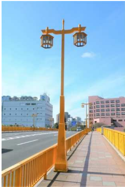
⑦平成初めの修景事業で改変された橋灯
