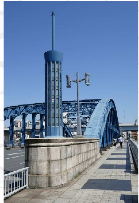
④ モダニズムデザインの駒形橋の橋灯
