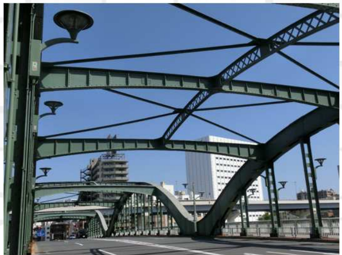
⑦厩橋のすっきりした上横構
