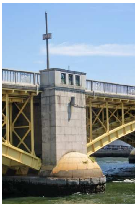
③蔵前橋のアルコーブと半球型の水切り
