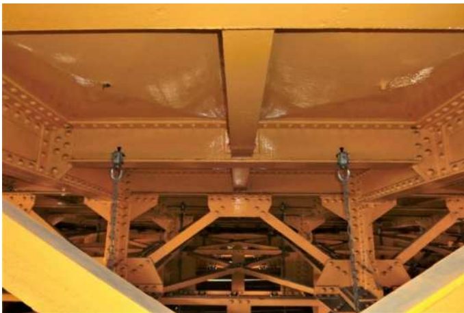
④蔵前のバックルプレート床版 8mm の鋼板でこの上にコンクリートが打設された
