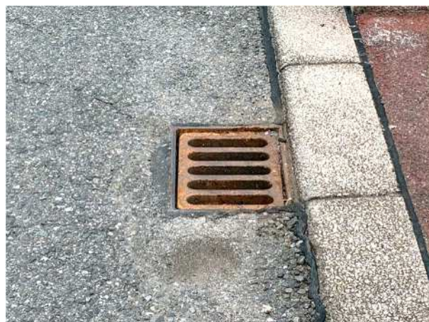
処置後の状況
