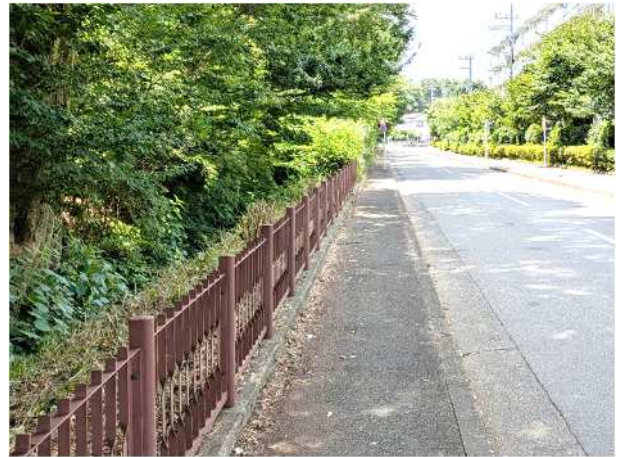
処置後の状況
