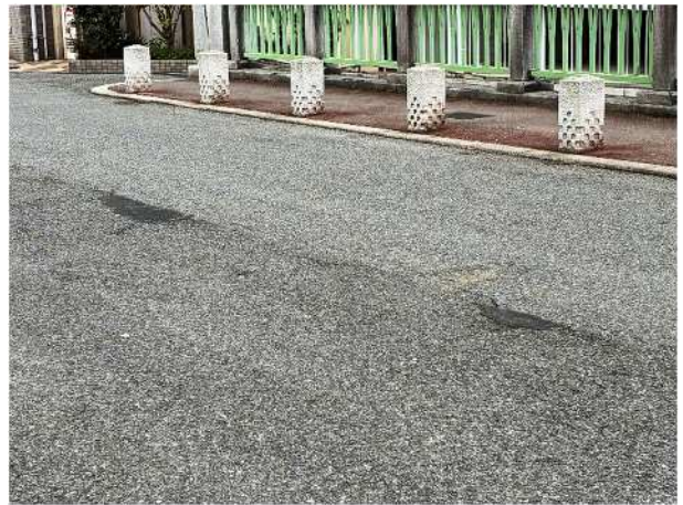
処置後の状況
