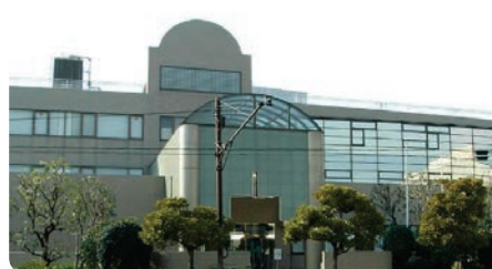
東京都土木技術支援センター 江東区新砂1丁目(令和7年)
