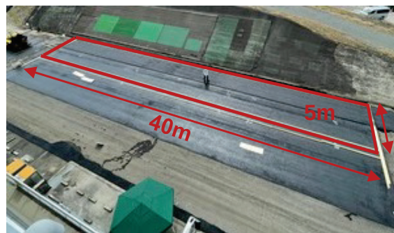
場内試験路面施工状況
