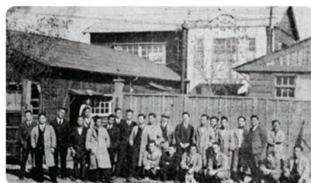
東京市土木局道路課試験所 港区芝浦3丁目(昭和3年)
