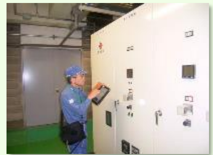
タブレットを用いた 巡回点検
