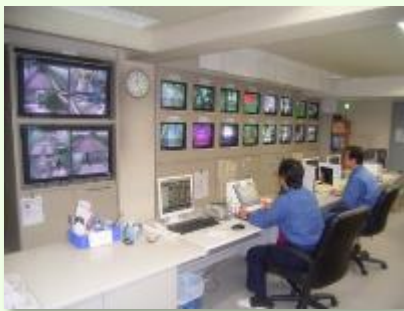
中央管理室における監視
