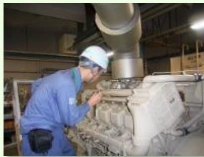
ディーゼル発電機の 負荷運転試験
