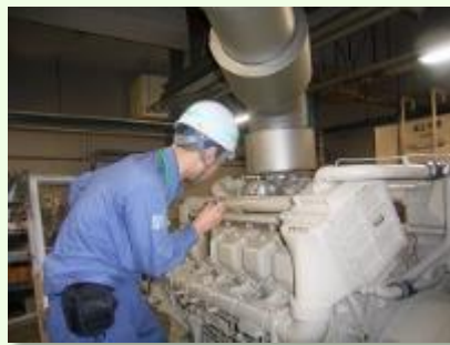
ディーゼル発電機の 負荷運転試験
