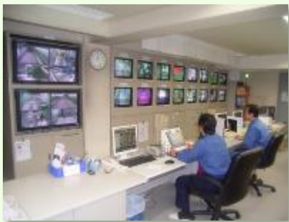
中央管理室における監視
