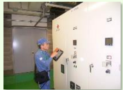
タブレットを用いた 巡回点検
