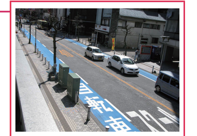
専用通行帯カラー塗装「溶融型路面カラー塗装」
